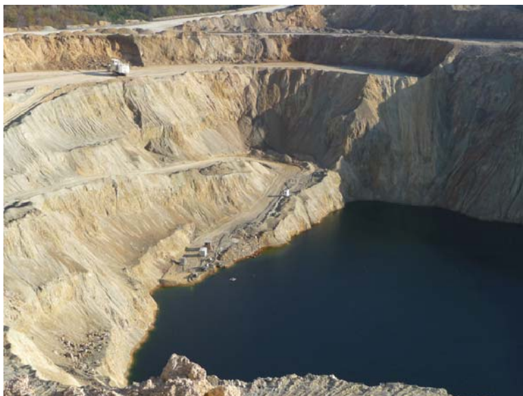
Слика 6: Површински коп "Церово 1" са потапајућом пумпом и цевоводом за одводњавање Извор: фотодокументација ИАУС, 2012. год.
