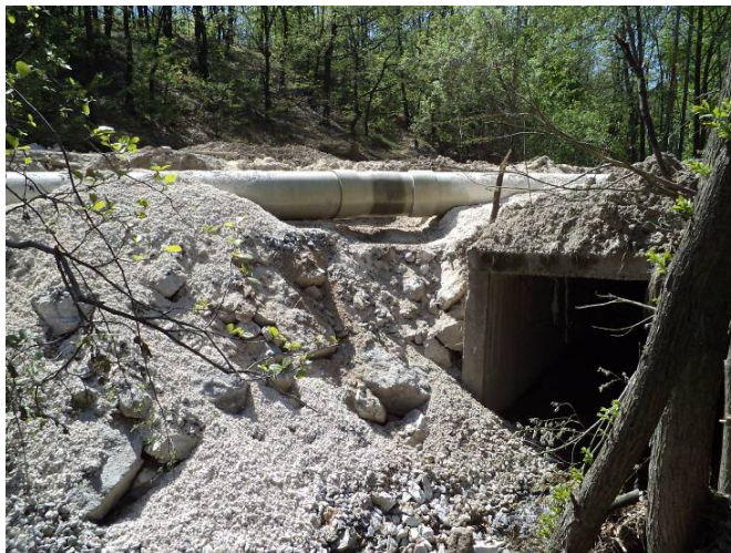
Слика 7. Детаљ преласка преко плочастог пропуста Извор: Служба експропријације РББ
