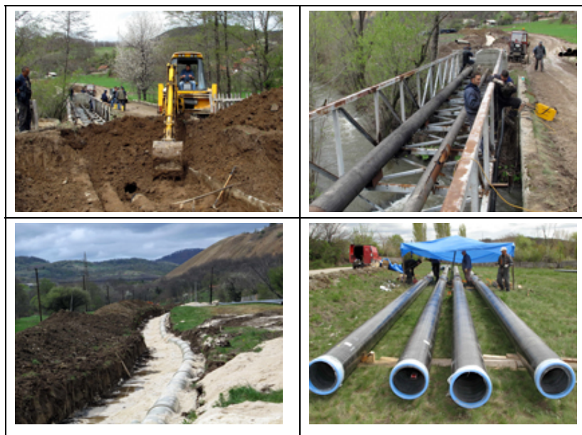
Слика 5. Детаљи са трасе током полагања цевовода Извор: http://www.rtb.rs/kolektiv/index.php?lang=Serbian
