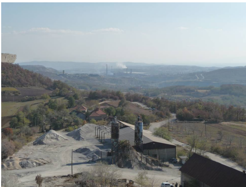
Слика 4: Поглед са површинског копа на управну зграду и складиште готових производа Извор: Фотодокументација ИАУС-а
